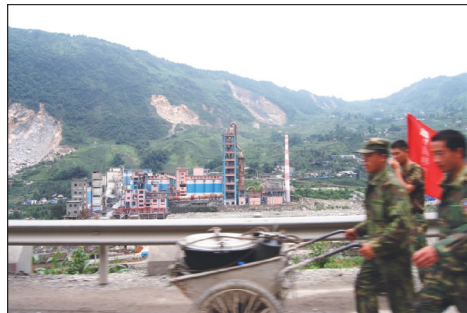
道路の復旧作業を続ける人たち（四川省汶川県）
